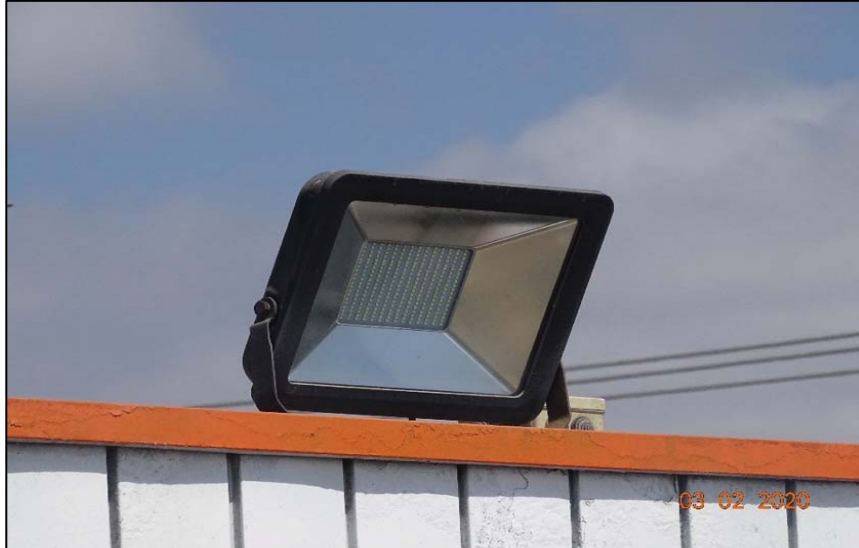
Imagen 3. Vista detallada luminaria, modelo LED de 50 w. 5
