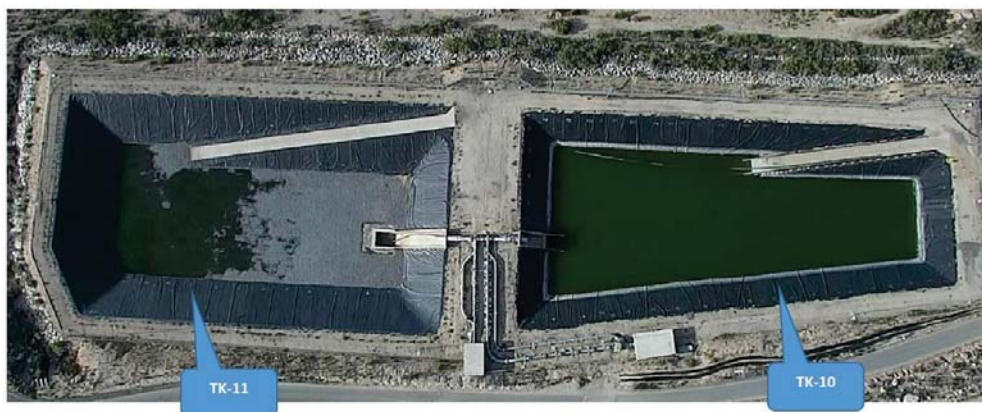
Figura N° 2 – Uso de piscinas de emergencia para almacenar aguas de proceso
