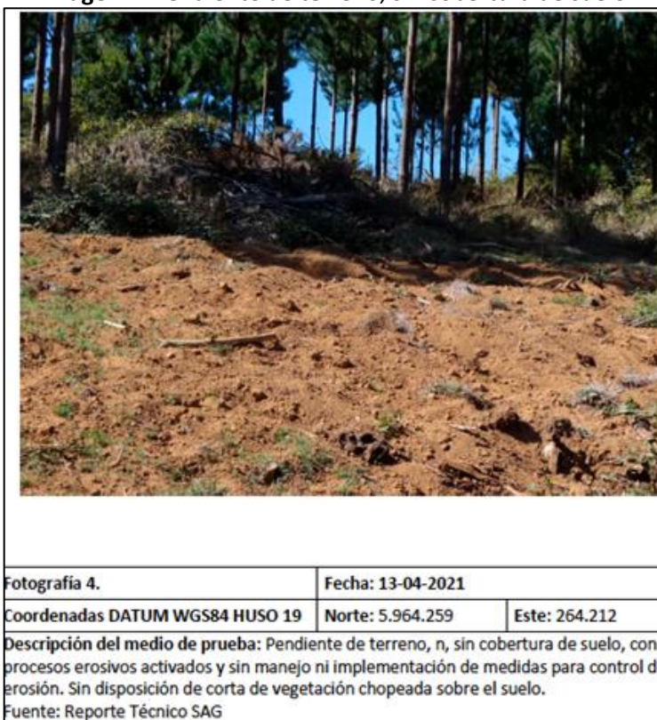
Imagen 4. Pendiente de terreno, sin cobertura de suelo.
