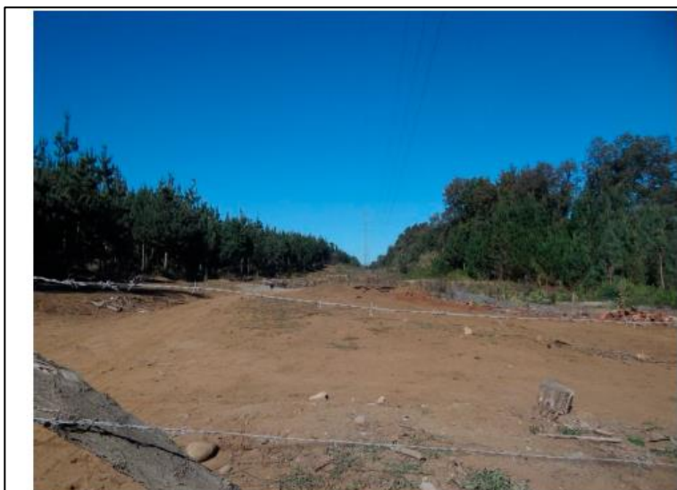
Imagen 3. Vista de línea de transmisión en zona de pendiente.
