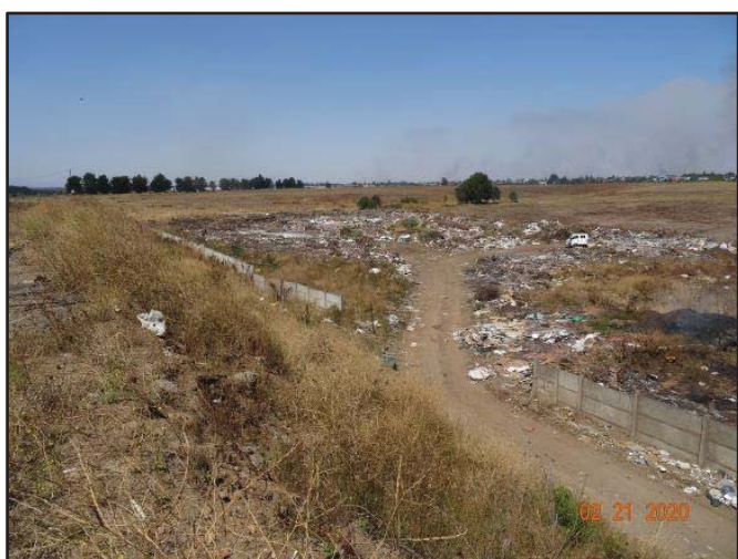
Imagen N° 9: ausencia de cerco perimetral en sector sur Vertedero Victoria evidenciando el acceso al microbasural.
