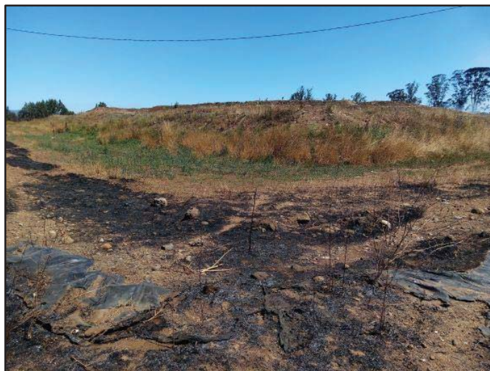
Imagen N° 20: sector Sur que colinda con microbasural donde se aprecia daño en la geomembrana por incendio ocurrido en el microbasural.
