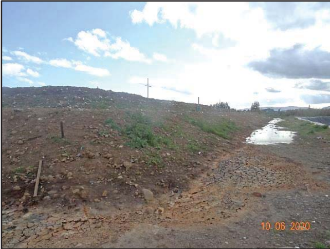
Imagen N° 14: zona Sur de piscina de lixiviados, con afloramiento de líquidos lixiviados en la base de zanja con terrazas de disposición de residuos.
