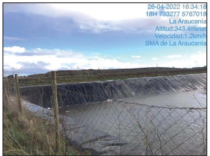
Imagen N° 17: piscina de lixiviados con acumulación de aguas lluvias.
