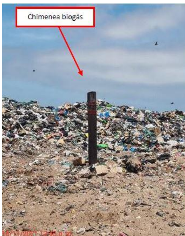
Imagen 8. Vista chimenea de biogás sin quemador de gases.
