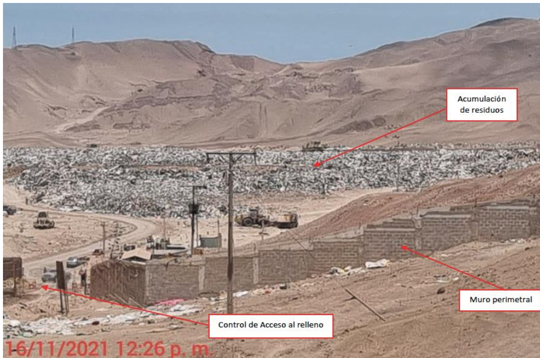
Imagen 2. Acercamiento relleno sanitario El Boro, sector entrada.
