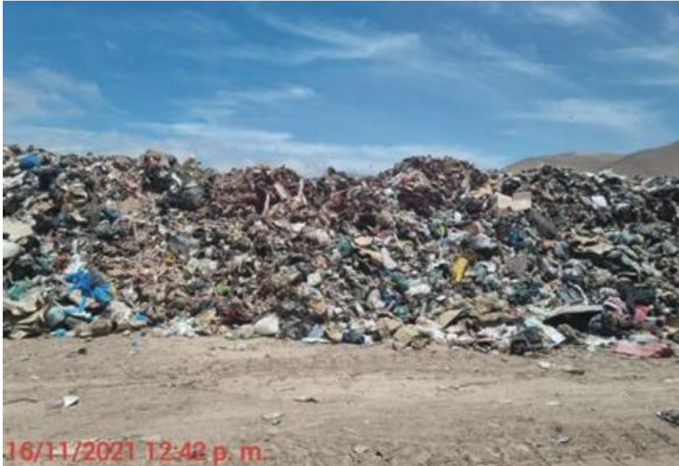
Imagen 3. Vista disposición de residuos relleno El Boro, sin cobertura ni compactación.
