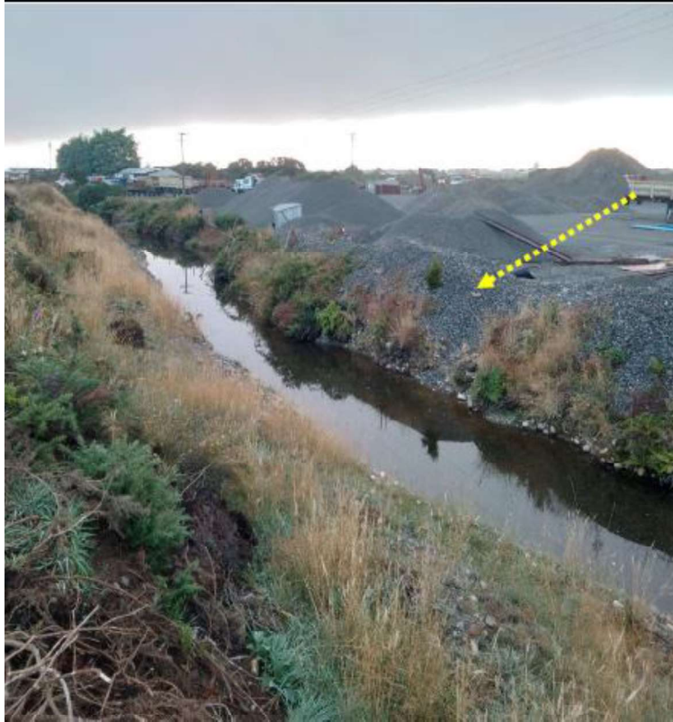
Imagen N°2: Vista del estero Chávez en zona aledaña a acopio de material árido, al 12 de marzo de 2021
