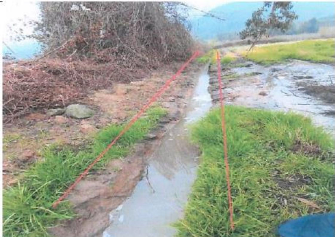
Imagen 2. Excavación de zanja perimetral a un costado de la zona de riego, para captación de escurrimientos superficiales
