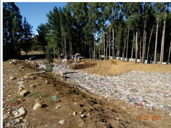
Imagen N° 6: frente de trabajo (E4), sin cobertura diaria de tierra en toda la zanja de disposición. Fecha: 22/04/2021.
