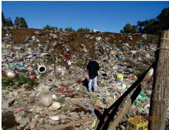
Imagen N° 3: E3 con RSD en superficie, sin contar con cobertura de tierra. Fecha: 22/04/2021.
