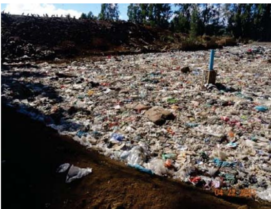
Imagen N° 5: zanja de disposición en frente de trabajo, sin cobertura diaria de tierra. Fecha: 22/04/2021.
