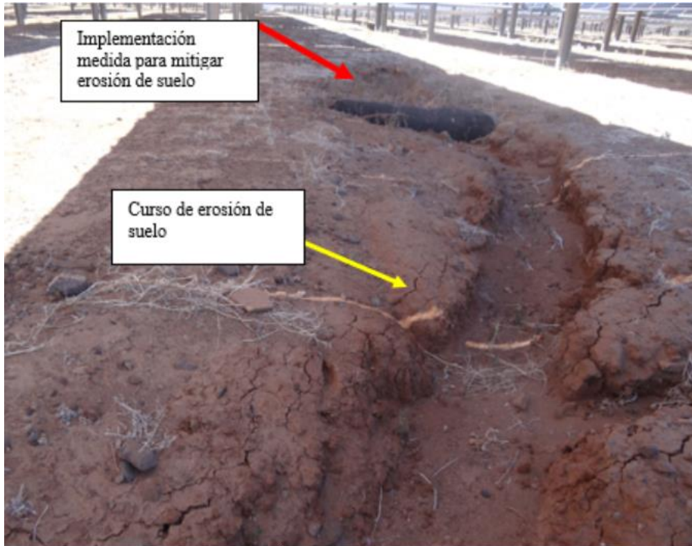
Imagen 8. Vista fenómeno de erosión y medida implementada.
