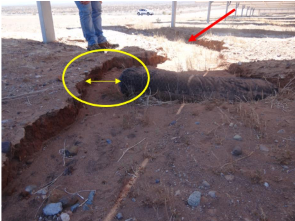
Imagen 9. Segunda vista fenómeno de erosión y medida implementada.
