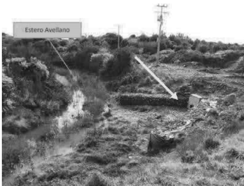
Imagen 11. Sector oeste de estero Avellano donde se encuentran las obras de canalización de aguas lluvias
