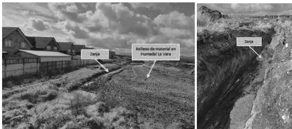
Imagen 6. Prolongación de la zanja longitudinal, que permite el escurrimiento de aguas naturales desde humedal La Vara, obtenida con fecha 28 de abril de 2022.
