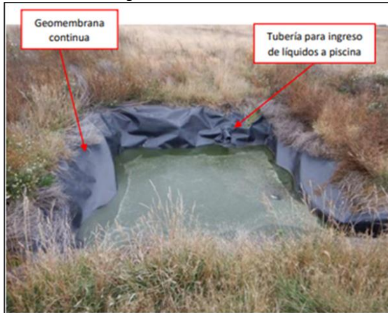
Imagen N° 4 - Piscina de lixiviados
