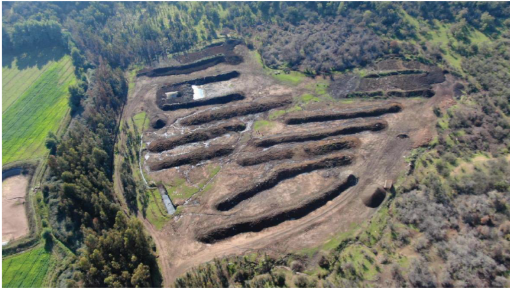
Imagen 4. Fotografía aérea en la cual se identifican canchas de acopio de residuos en el sector N°2 del proyecto
