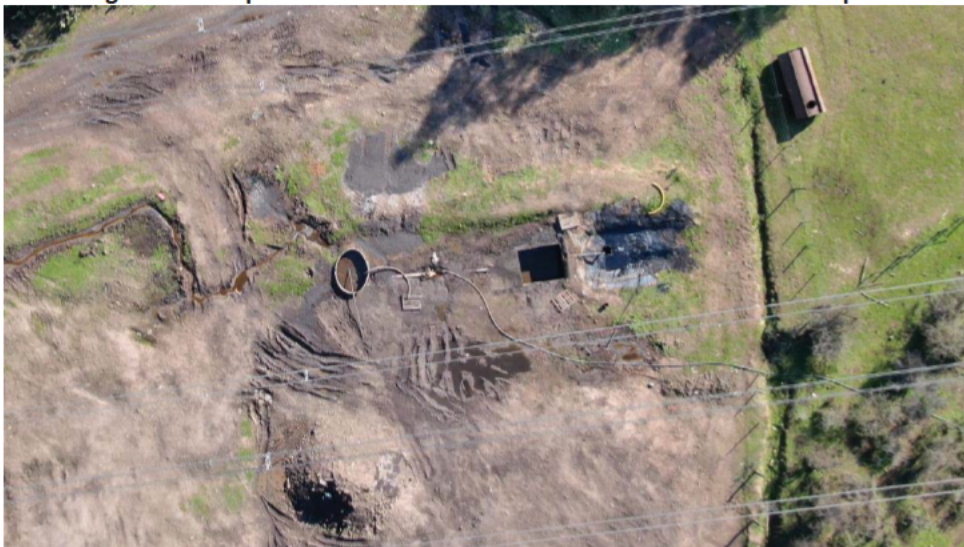
Imagen 7. Estanques de acumulación de lixiviados del Sector N° 1 de la planta
