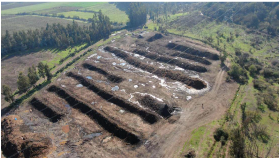
Imagen 5. Sector N° 1 de la Planta de compostaje, en donde se observan líquidos lixiviados acumulados y escurriendo desde diversas pilas de compostaje
