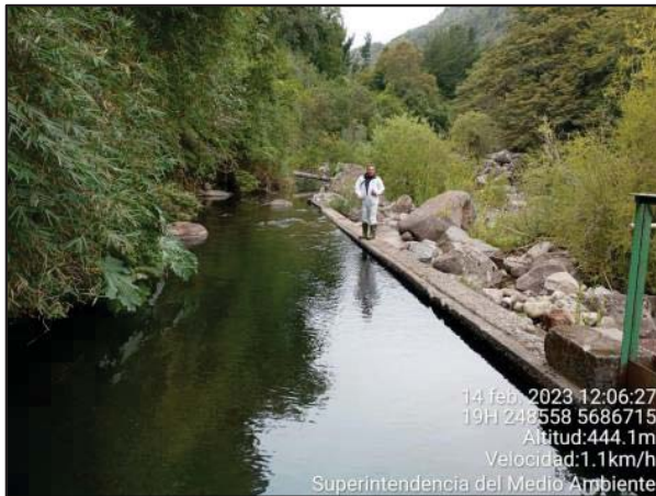
Imagen N° 10: Sector bocatoma de la Piscicultura Curacalco. Por el lado izquierdo, se observa agua que se dirige a la piscicultura. El agua sobrante, escurre por distintas aberturas o roturas de la barrera al lado derecho.
