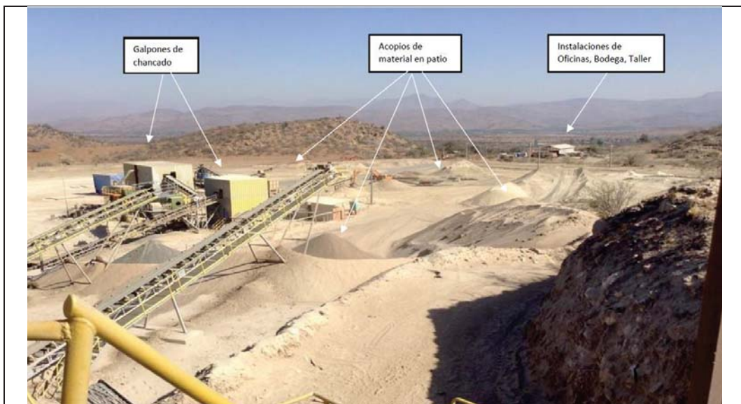
Imagen 4. Panorámica desde el sector de emplazamiento del chancador primario sin procesar materiales que da cuenta que no se evidencian emisiones
