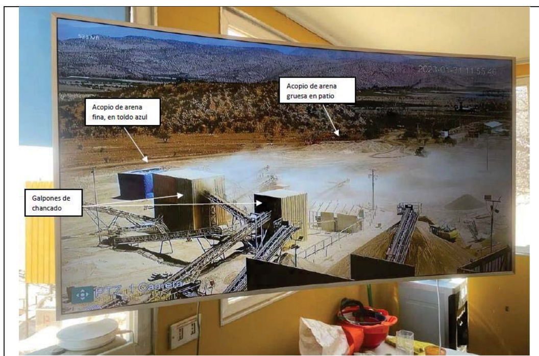
Imagen 1. Proceso de chancado efectuado en dos galpones metálicos y con cintas transportadoras, que evidencia el proceso sin medidas de control de emisiones de MP fino
