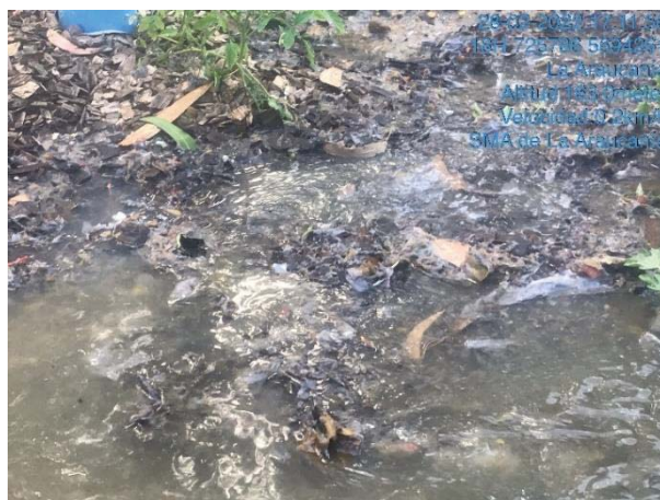
Imágenes 3 y 4: Acumulación de residuos sobre el lecho del módulo de lombrifiltros, donde se aprecia costra grisácea que se descompone y genera un foco de malos olores.
