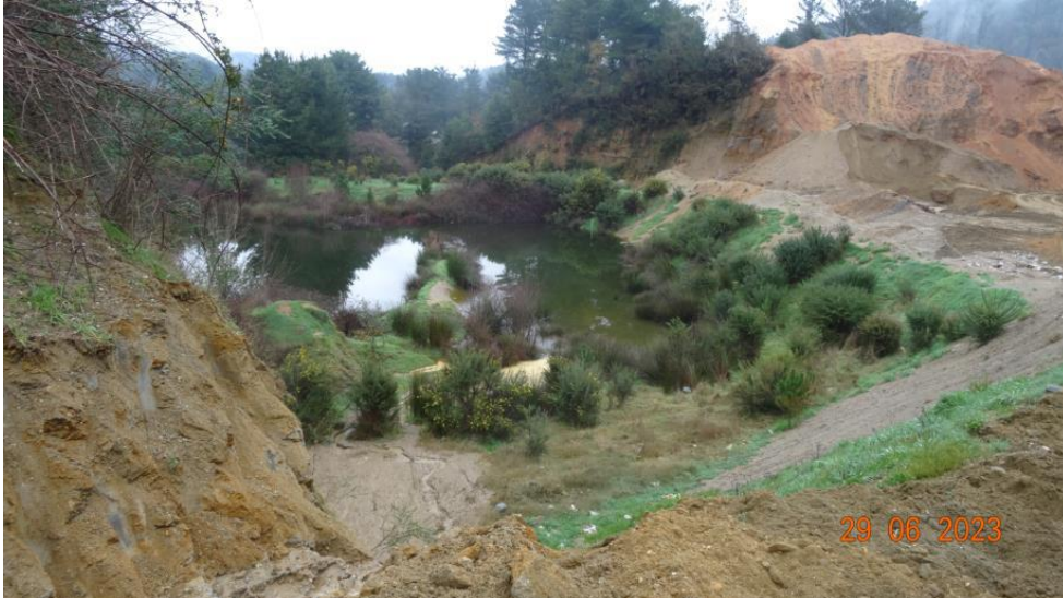
Imagen N° 8. Piscina de lixiviados del Vertedero Morompulli
