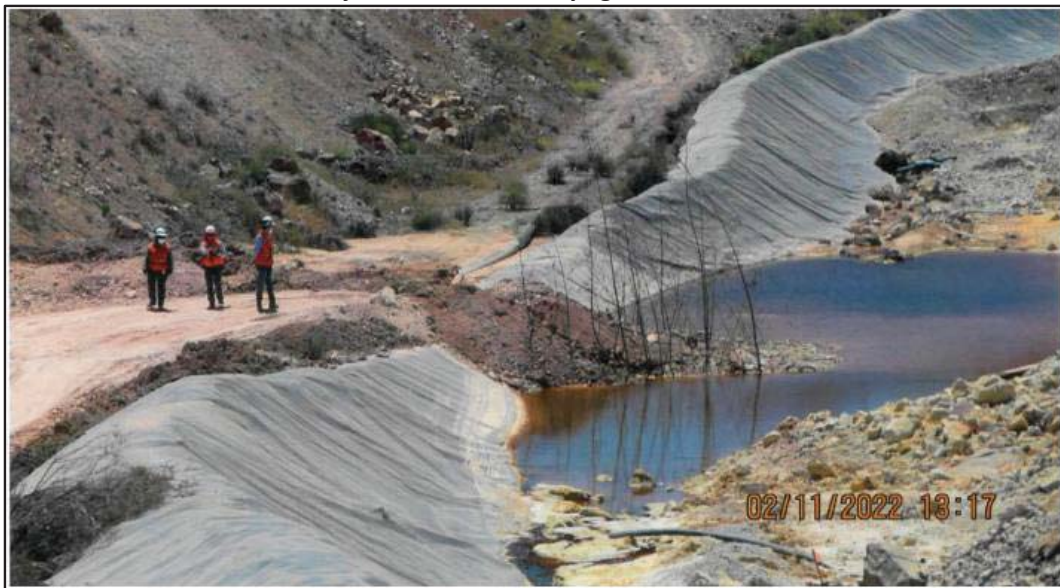
Imagen 2: Zona de recepción de aguas en pie Pila ROM Lixiviación proveniente del Sistema de Drenaje Muro Oriente Sur y aguas de filtración
