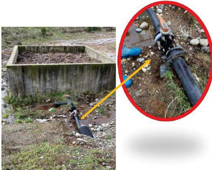
Imagen 5. Desconexión de tubería que llega al biofiltro.
