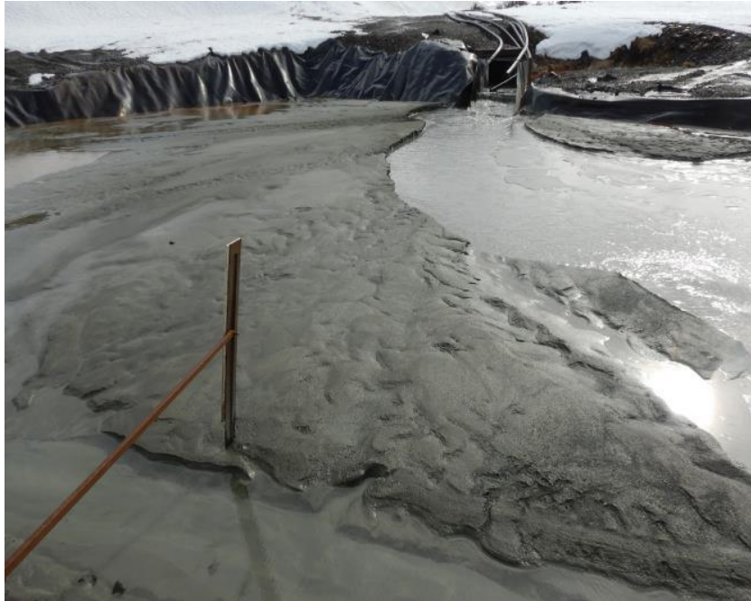
Fotografía 3. Piscina de sedimentación, inspección 11 de agosto 2022.
