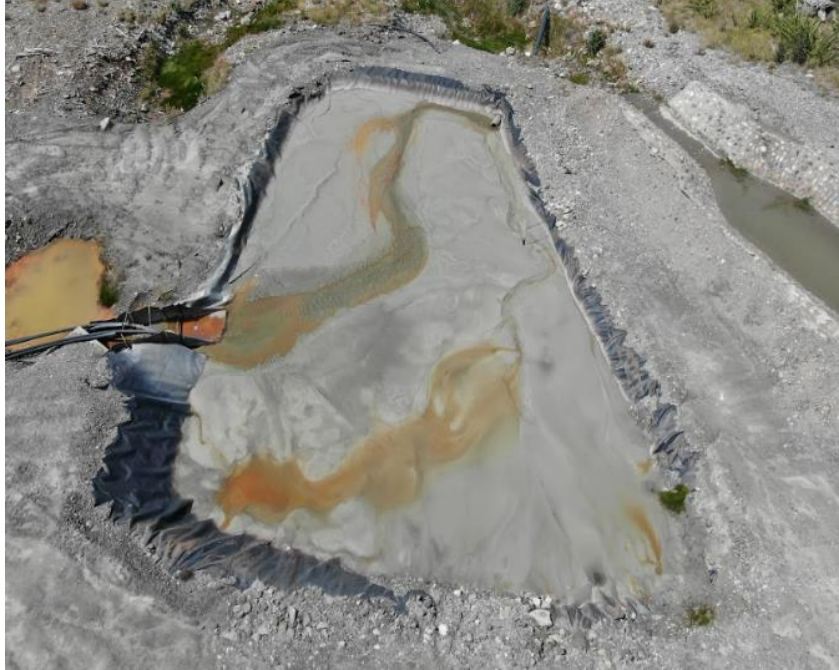
Fotografía 5. Piscina de sedimentación, inspección 16 de febrero 2023.
