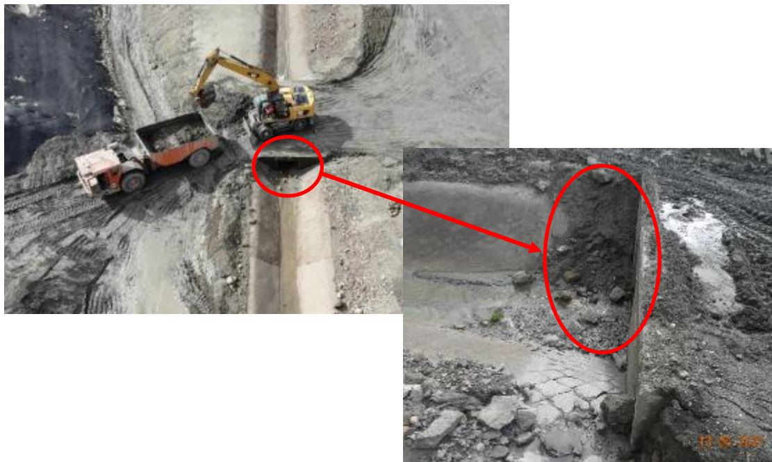
Fotografía 6. Retroexcavadora cargando material sobre el puente de acceso al Depósito.
