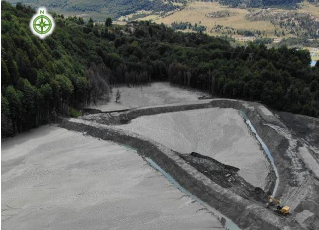
Fotografía 12. Imagen con dron, inspección 22 de febrero de 2023.
