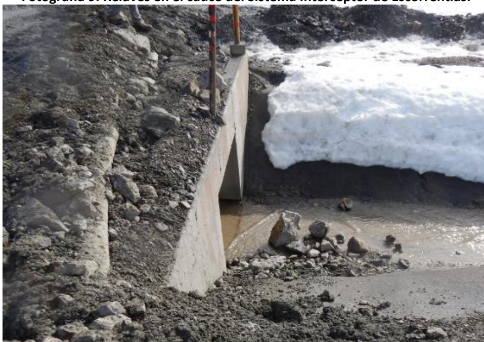
Fotografía 9. Relaves en el cauce del Sistema Interceptor de Escorrentías.
