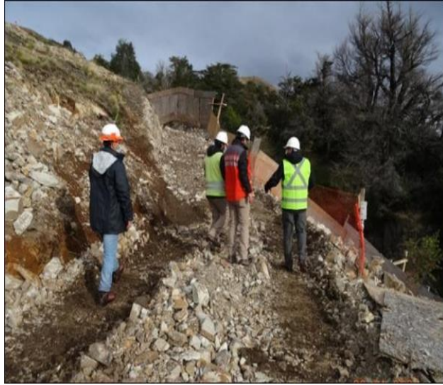
Imagen 3. Vista del trazado de la tubería de baja presión. Sector excavado con martillo
