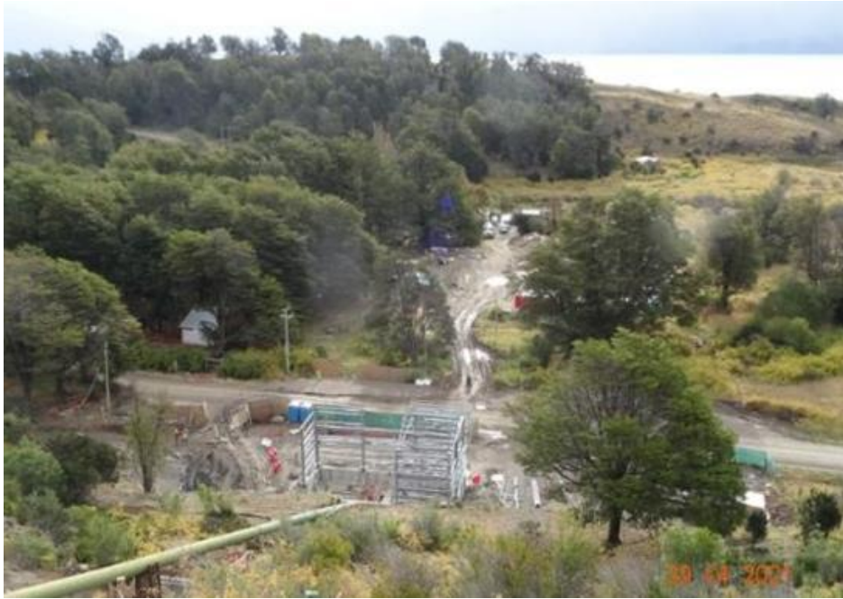
Imagen 5. Vista de la tubería de presión y la casa de máquinas, en el plano inferior. Al otro lado del camino se ubican oficinas y bodegas de la constructora
