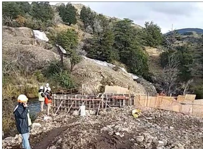
Imagen 4. Vista de la instalación de las tuberías de baja presión
