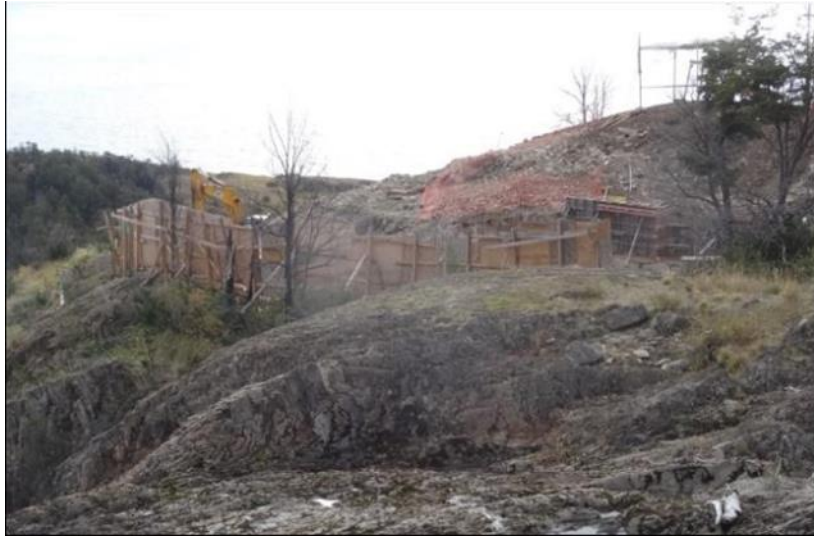
Imagen 7. Vista desde la terraza superior. Al fondo se aprecian las obras de rehabilitación de la CH Los Maquis
