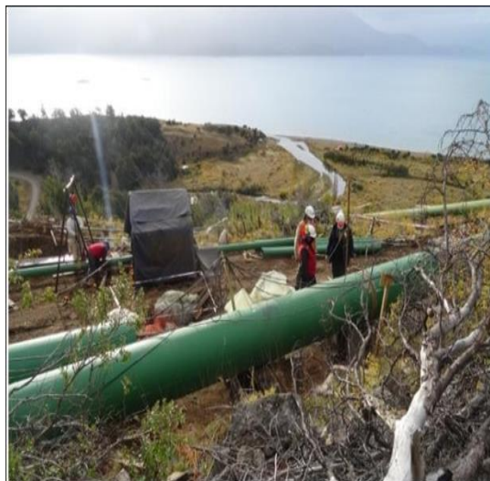
Imagen 2. Visita de la instalación de las tuberías de baja presión
