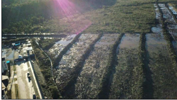
Imagen 19. Franjas de escarpe y despeje de vegetación ejecutadas
