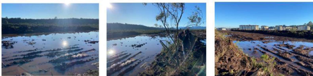
Imágenes 16, 17 y 18. Condiciones de anegamiento del área intervenida
