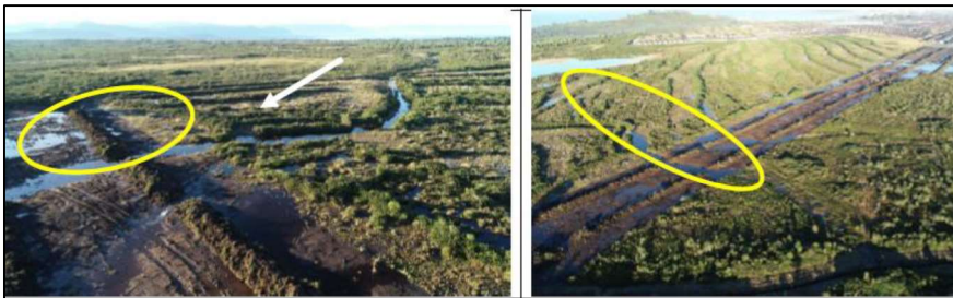
Imágenes 20 y 21. Intervención de estero proveniente de laguna denominada “Parque Laguna II”
