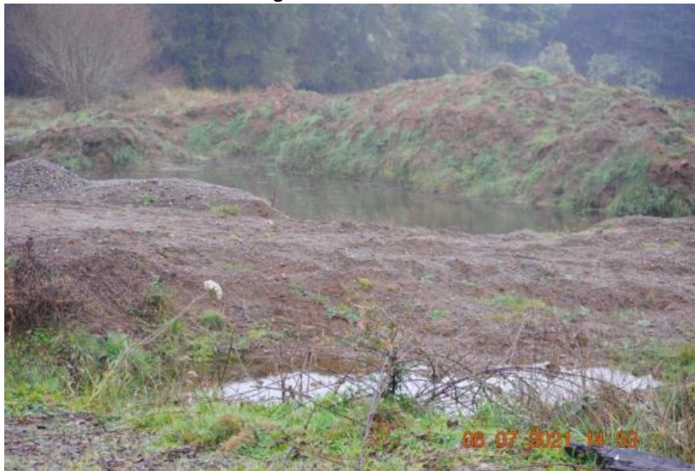
Imagen 5: PÉRDIDA DE SUELO
