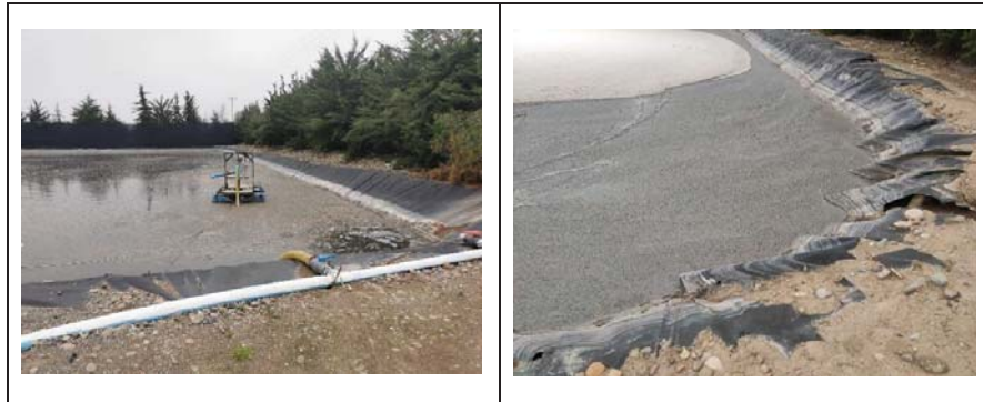
Imagen 4: Presencia de lodos en la superficie de las lagunas
