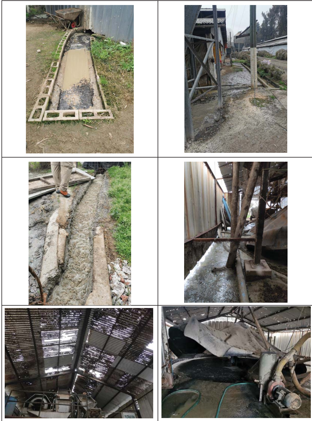
Imagen 5. Muestra escurrimientos de purines en suelo desnudo y por canaletas, en distintos sectores de pabellones, estanque homogeneizador y sistema de prensado, 30 de agosto 2022.
