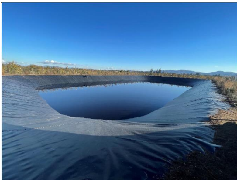
Imagen 3. Tranque de acumulación de RIL
