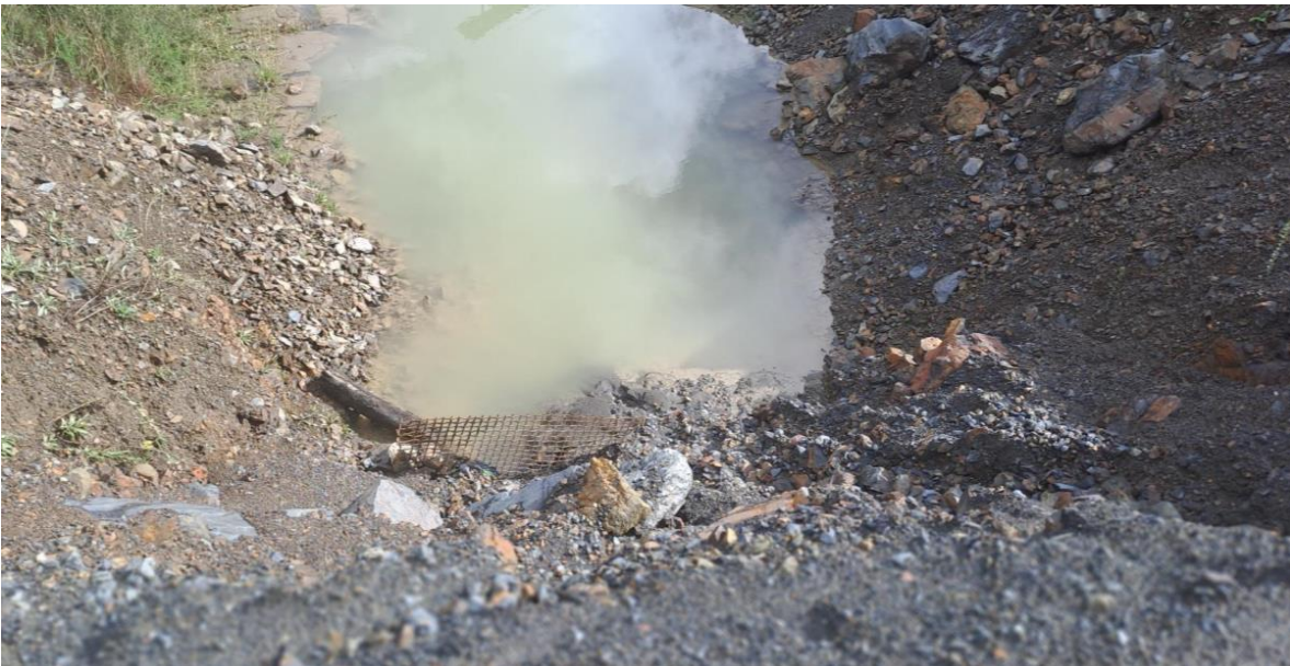
Imagen 4. Sector donde debería estar ubicado el sedimentador
