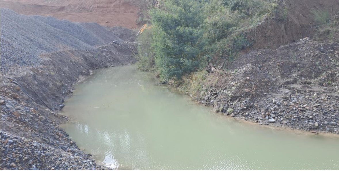
Imagen 3. Acumulación de aguas lluvias dirigidas hacia el punto de descarga
