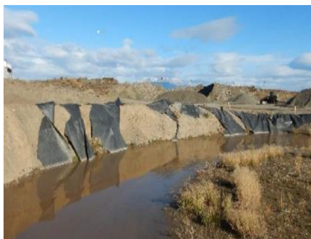
Imagen 9 y 10. Piscinas de lavados de áridos donde se observan roturas en la membrana
