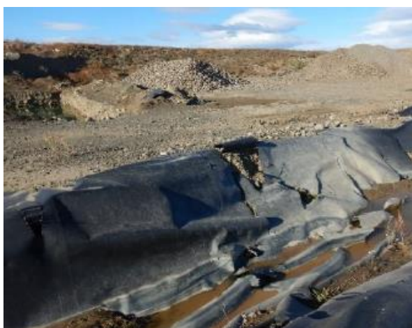
Imagen 9 y 10. Piscinas de lavados de áridos donde se observan roturas en la membrana
