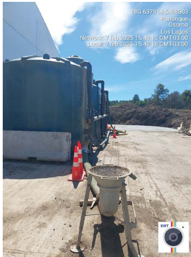
Imagen 3. Pichón para transportar líquidos lixiviados desde los estanques de acumulación
