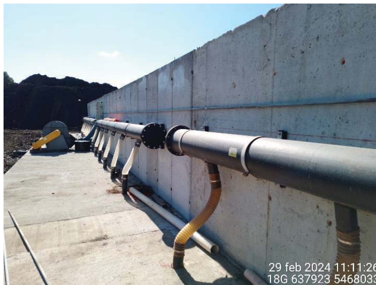
Imágenes 13 y 14. Sistema de conducción de aire en el sistema de pisos de aire.
