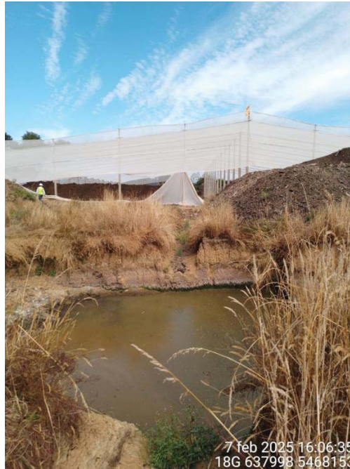
Imagen 10. Fosa de aguas lluvias en excavado en terreno natural, con aguas de tonalidad café verdosa en su interior
