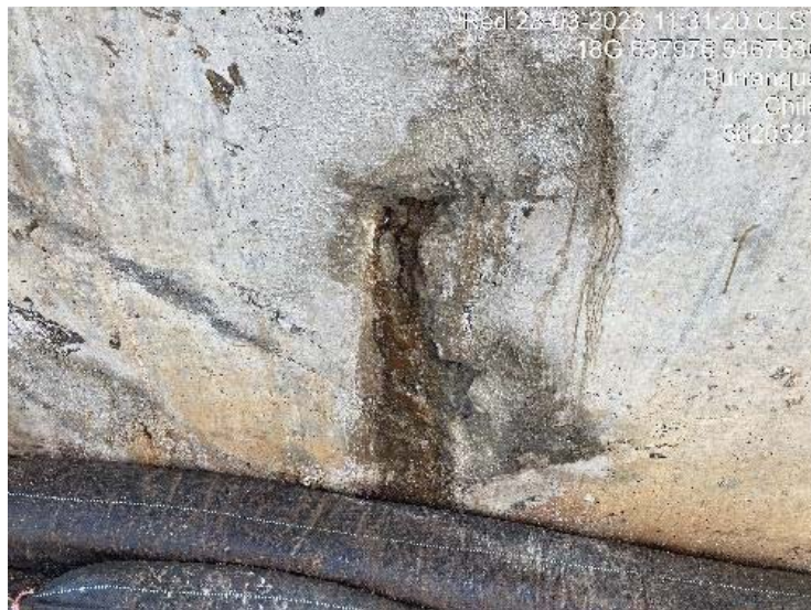
Imagen 1. Fractura en el hormigón lateral de trinchera de compostaje
