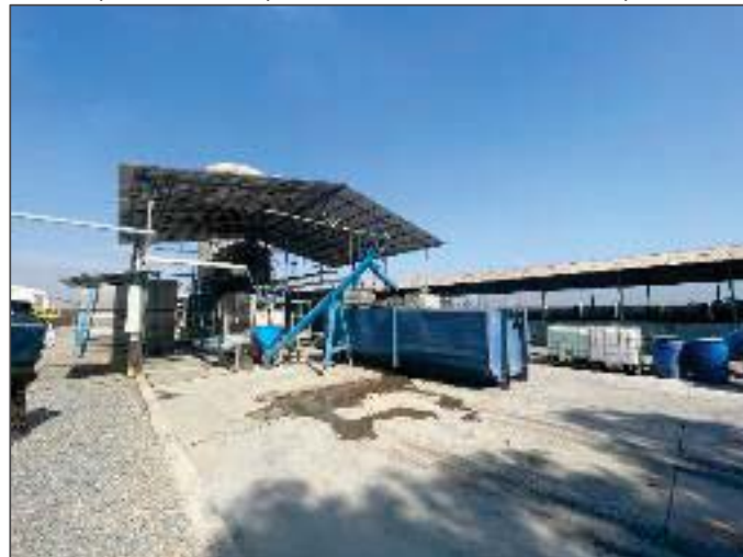
Figura N°6: Sistema de tratamiento fisicoquímico, equipo DAF, filtro prensas de lodos, tolva recepción de lodos para ser enviado a terceros a disposición final.
