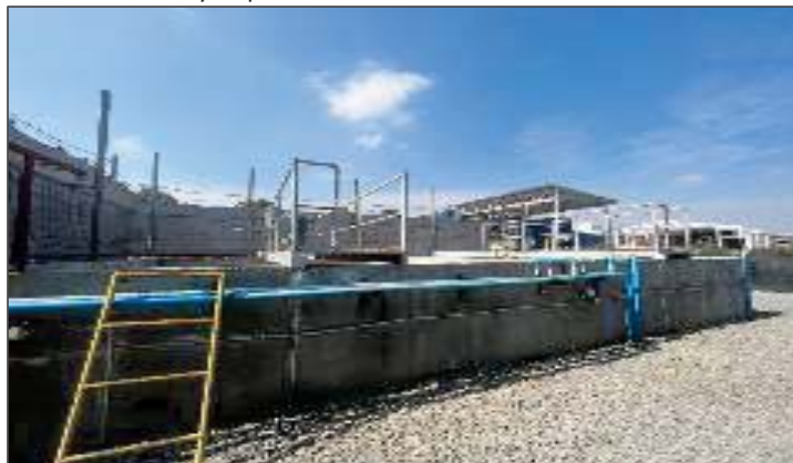
Figura N°7: Estanques de sistema de lodos activados. Esta unidad se encuentra destapada y se perciben notas de olor molestos.
