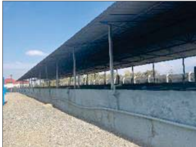
Figura N°8: Cuna de sistema Tohá sin operación y en abandono.
