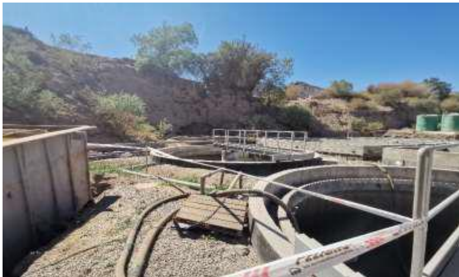
Fotografía N° 2. Sedimentadores que no se encuentran operativos.
