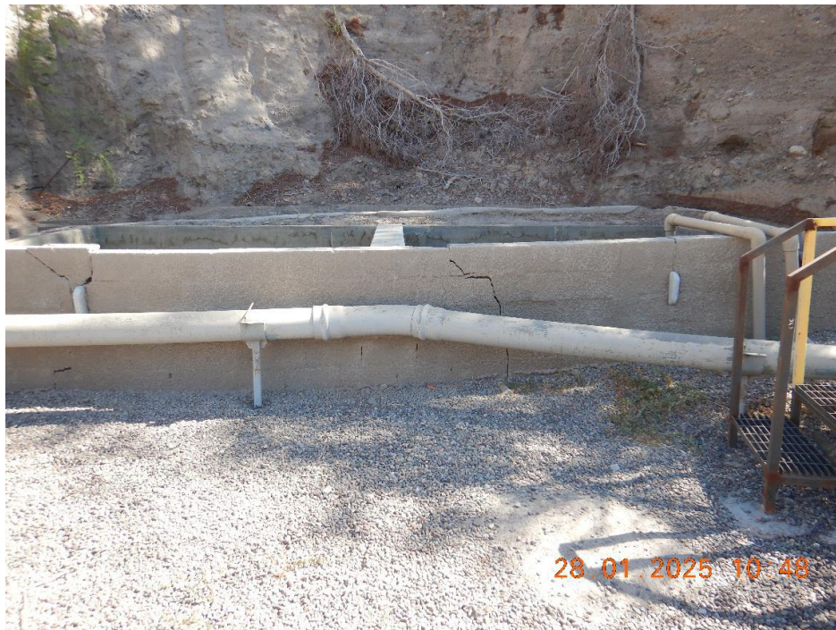
Fotografía N° 3. Ecualizadores y estanques reactores no habilitados.
