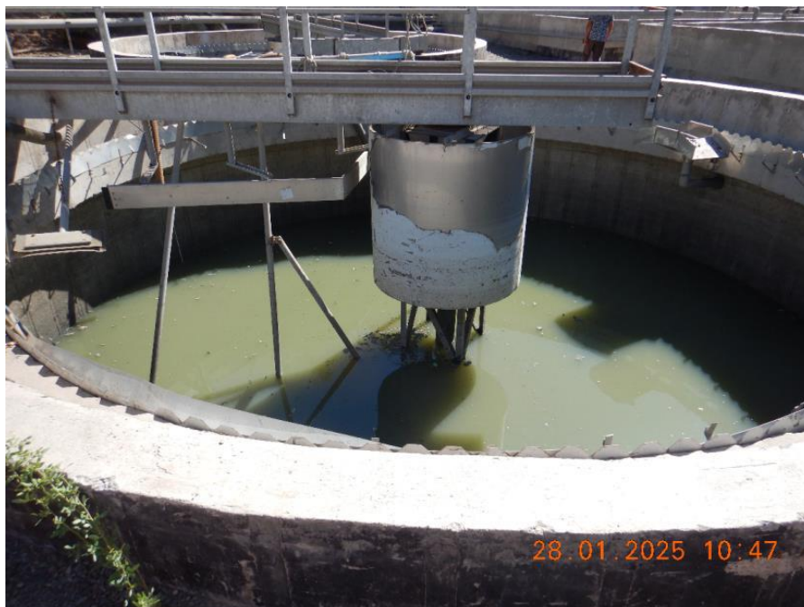
Fotografía N° 4. Clarificador utilizado como estanque de acumulación de aguas servidas.
