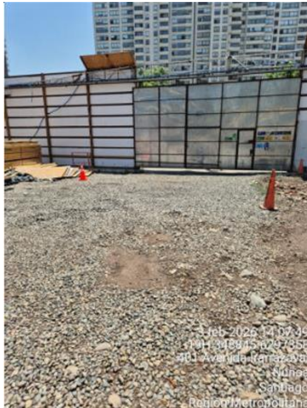
Figura 2. Cierre perimetral en deslinde norte.
