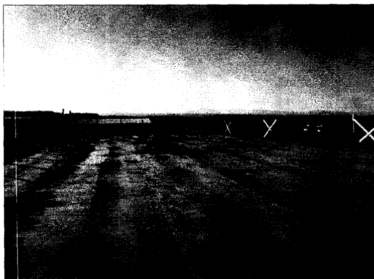
Despeje y habilitación del área para instalar el patio de salvataje provisorio
