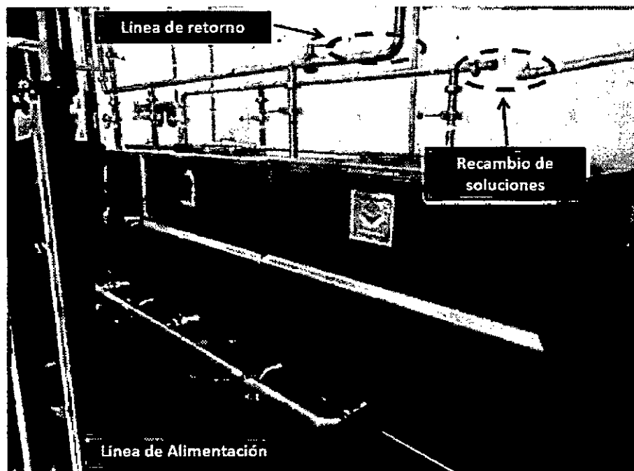
Ilustración 4 CIP del Evaporador y sus tuberías
