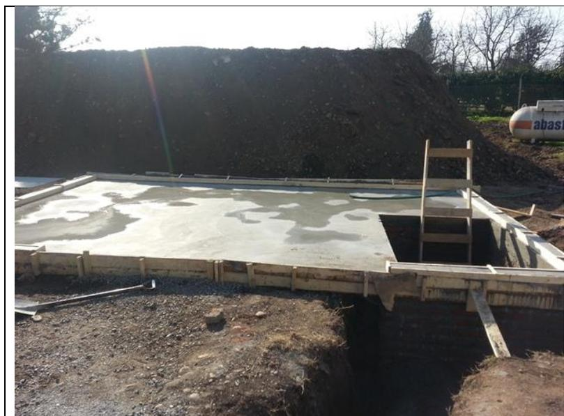
**Fig. 5 – Confección Losa Pretratamiento (Donde está instalado el Filtro Rotatorio Actualmente)**
