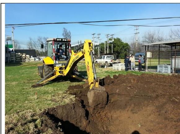
Fig. 8.- Excavación Piscina de decantación
