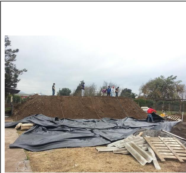
Fig. 10.- Inicio de la instalación del revestimiento del tranque
