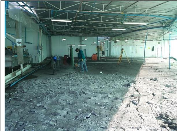
Figura 14.- Piso Zona 2 de proceso Antiguo - Demolición
