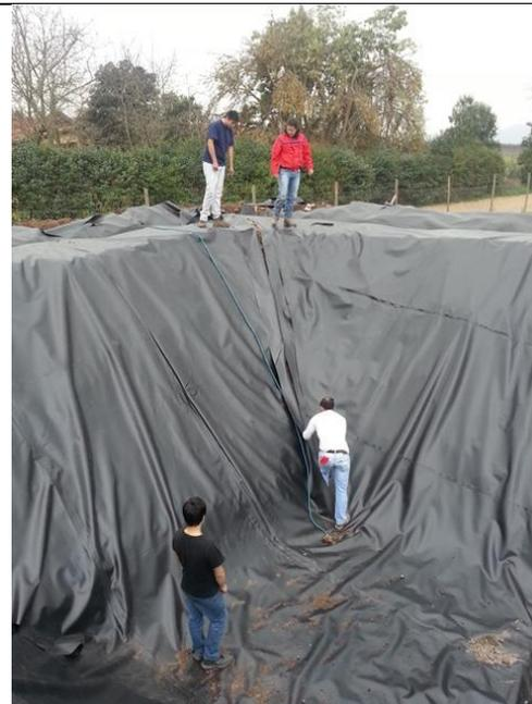
Fig. 11.- Conformación Fondo Piscina de decantación – Revestimiento.
