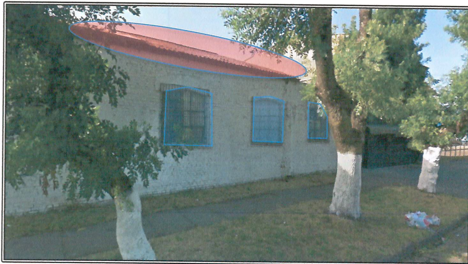
Figura 9. Vista desde el exterior mejoras en ventanas y revisión de muro con techumbre.
