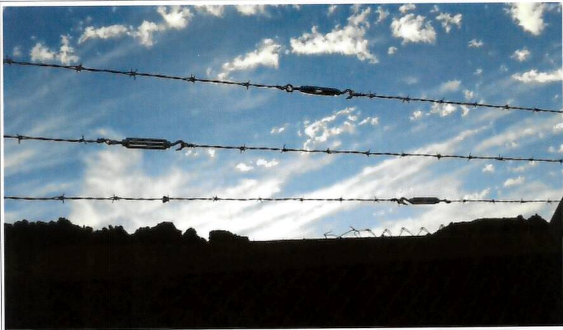
Foto 10. Tensores de Alambres en Cerco
