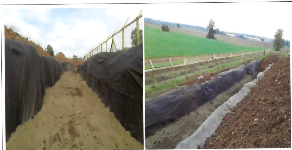
Foto 4 y 5. Membrana Geotextil instalada
