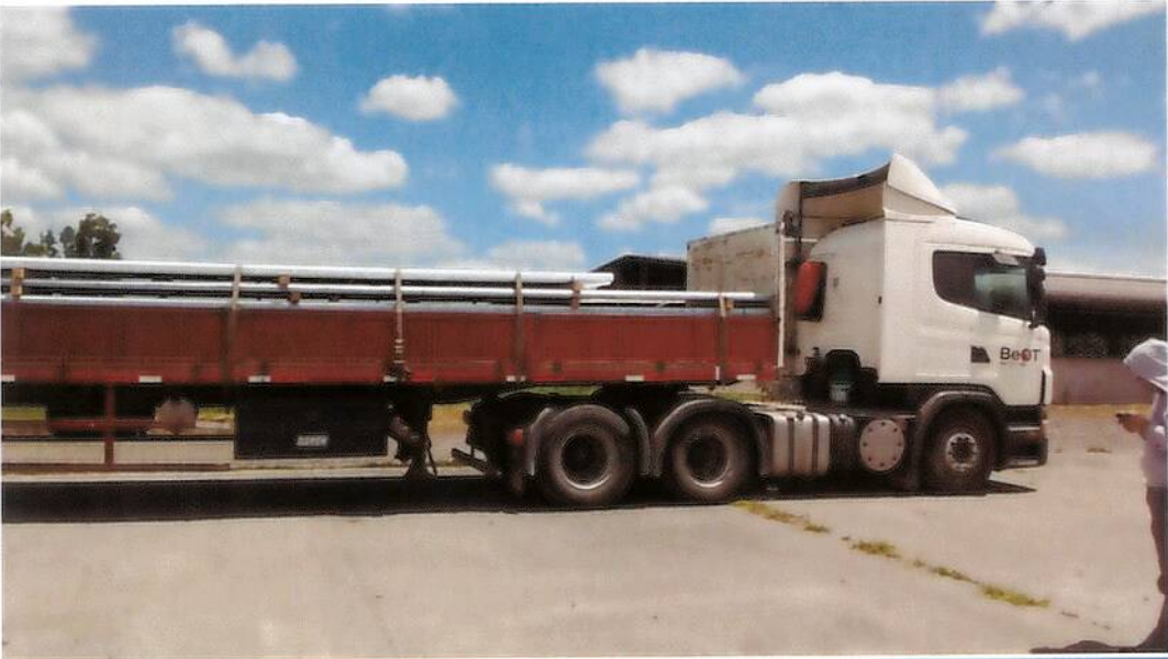
Recepción y acopio de planchas para cambio de techumbre , galpón de engorda Agrícola Mollendo
