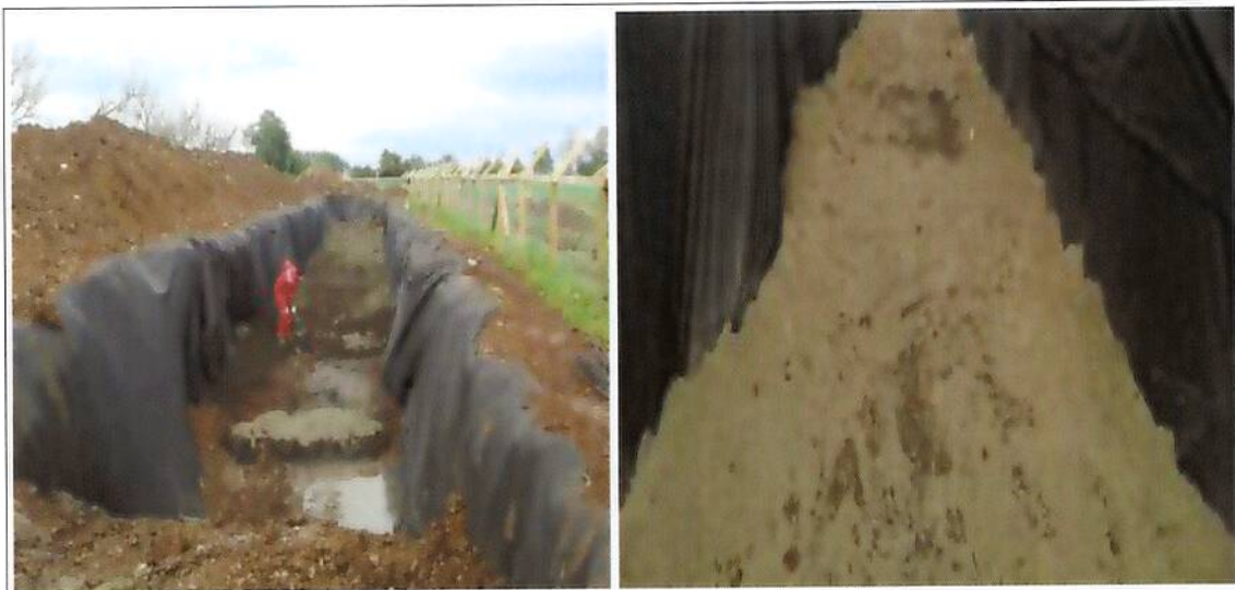
Foto 2 y 3. Cama de Arena de e = 10 cm
