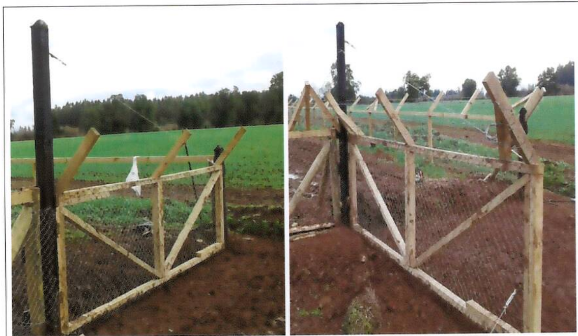
Foto 8 y 9. Portón de Acceso
