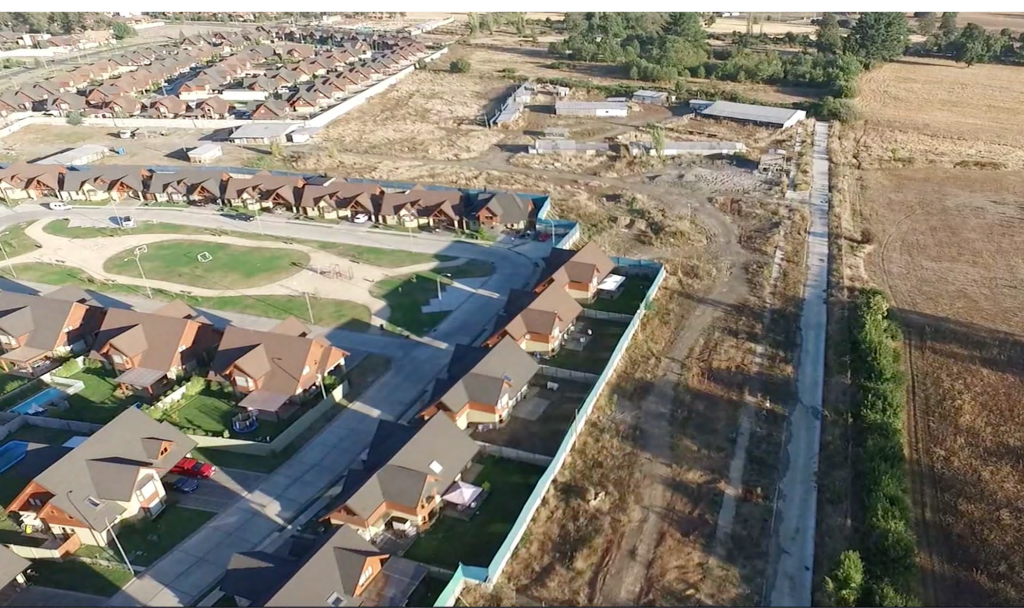
Vista deslinde: Poniente Extensión
