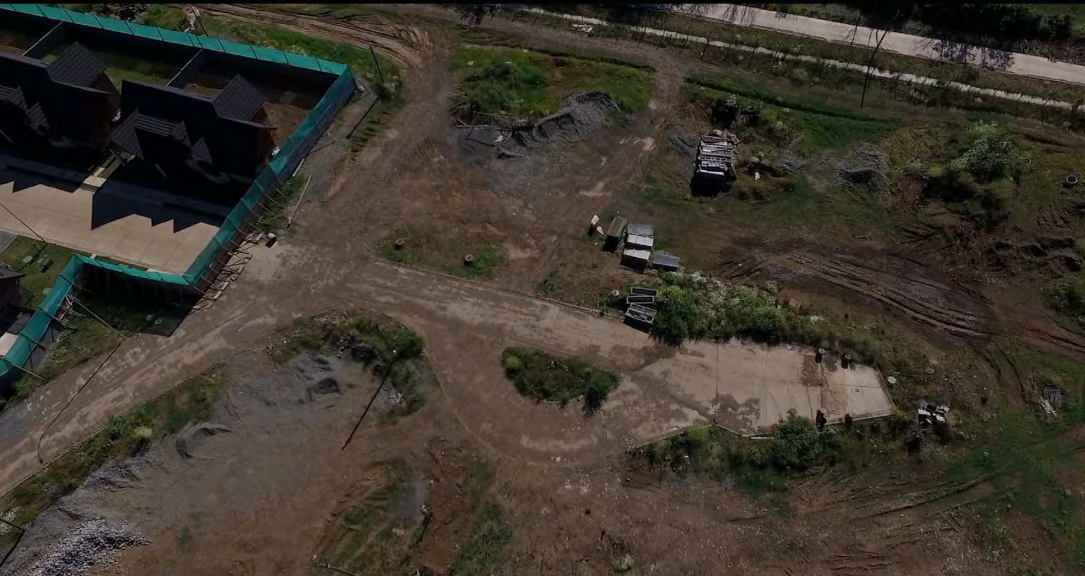
Vista deslinde: Central Poniente 1
