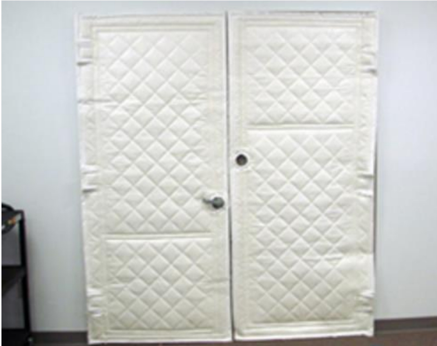
Figura 4. Material propuesto para cierre de vanos conectados con pasillos o piezas contiguas.
