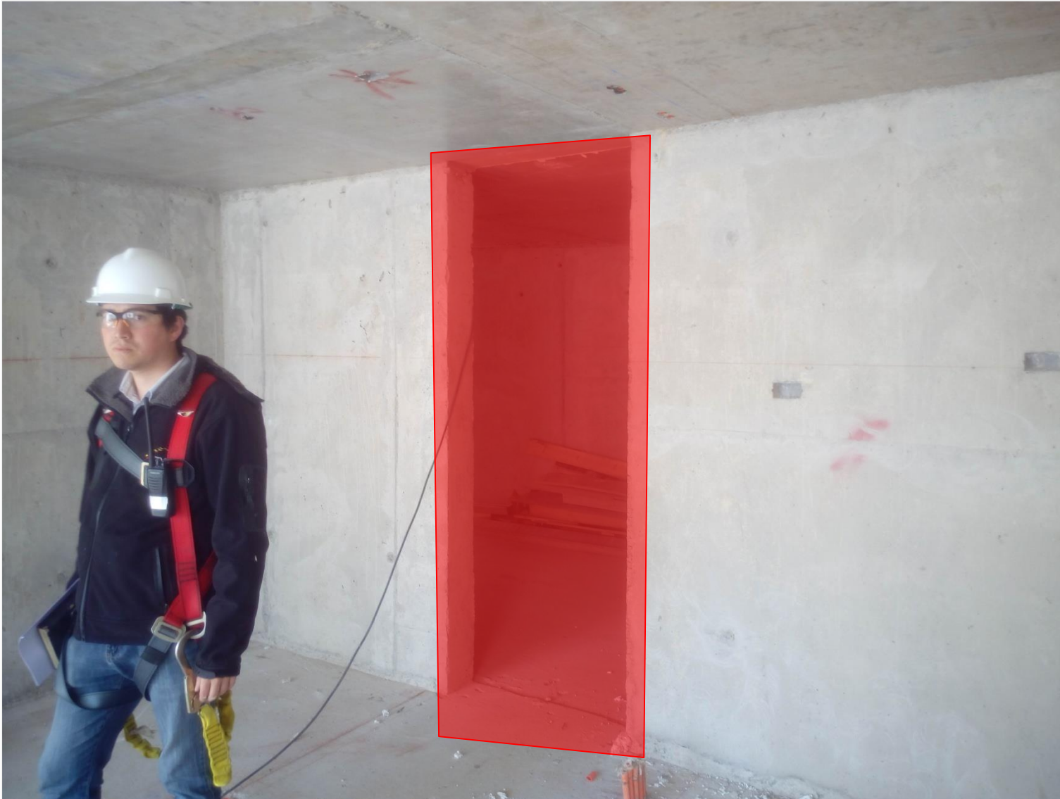
Figura 3. Ejemplo cierre de vanos conectados con pasillos o piezas contiguas.
