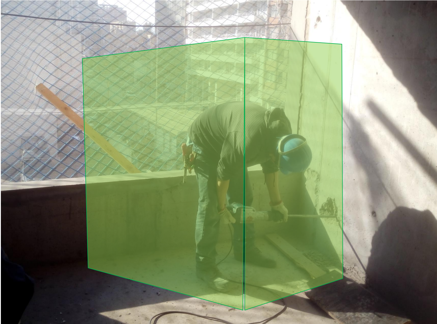
Figura 5. Ejemplo uso de pantallas móviles en faenas ubicadas en cubierta o en sectores al aire libre.
