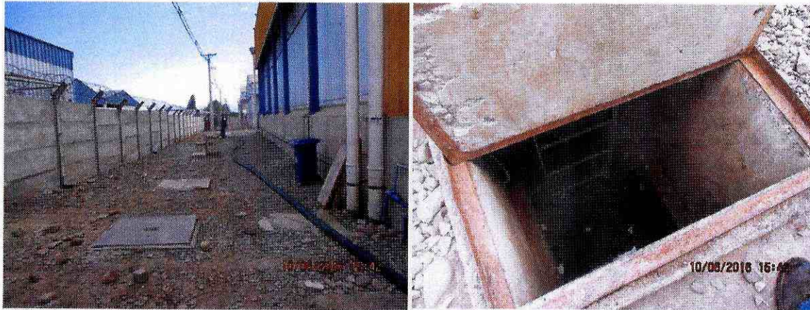
Figura 9. Vista de Sistema de Infiltración Actual
