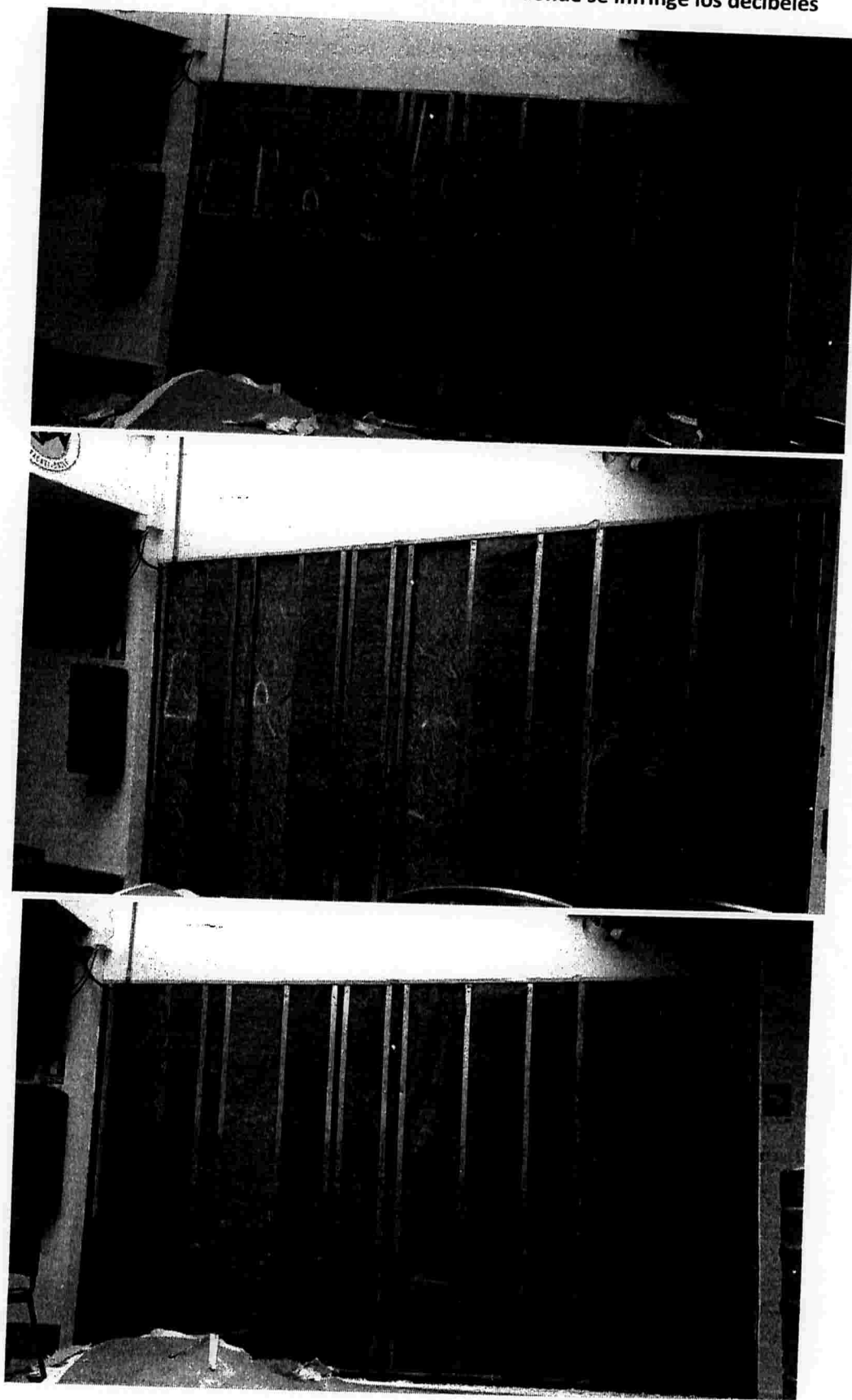
Muro colindante con punto de medición en donde se infringe los decibeles
