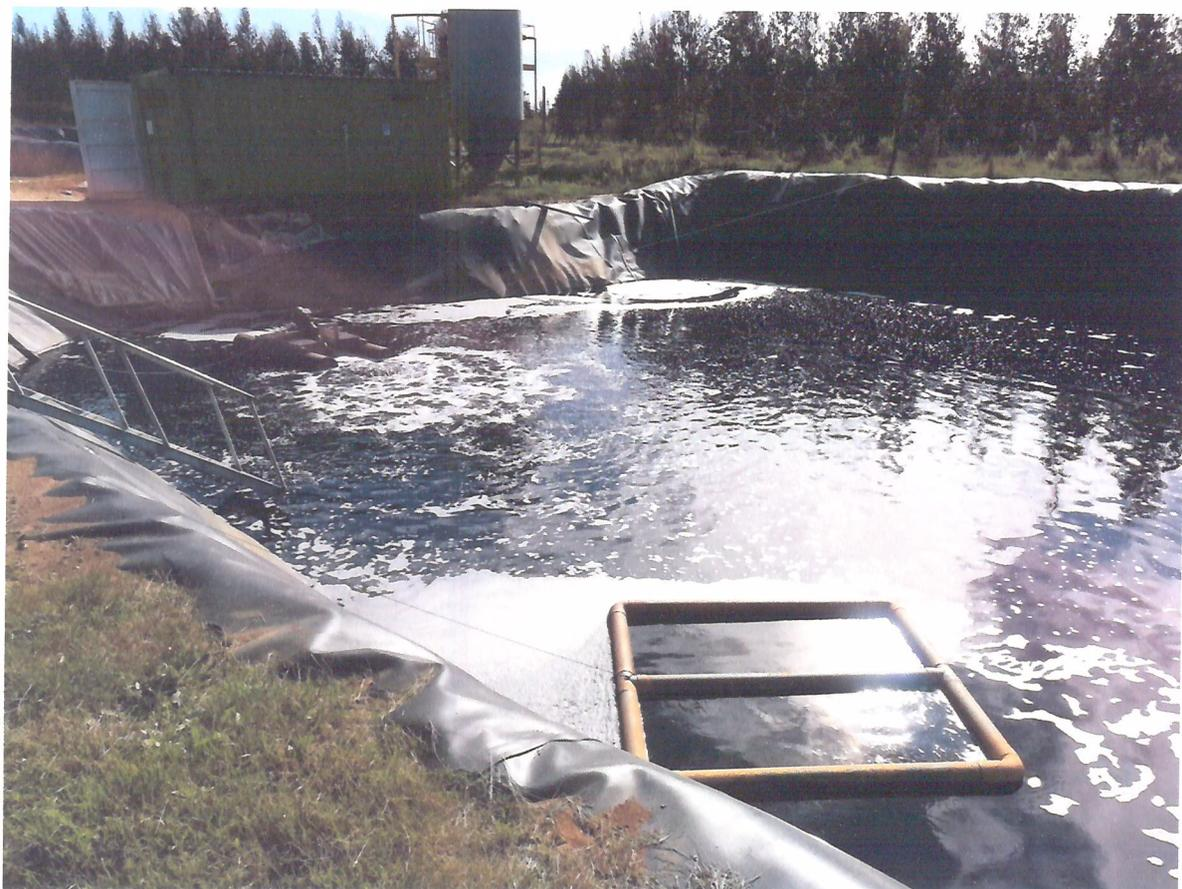
**Figura 6:** Piscina de percolados, corresponde a la piscina receptora de líquidos percolados provenientes del Relleno Sanitario. Se destaca tubería de descarga de los líquidos lixiviados.
