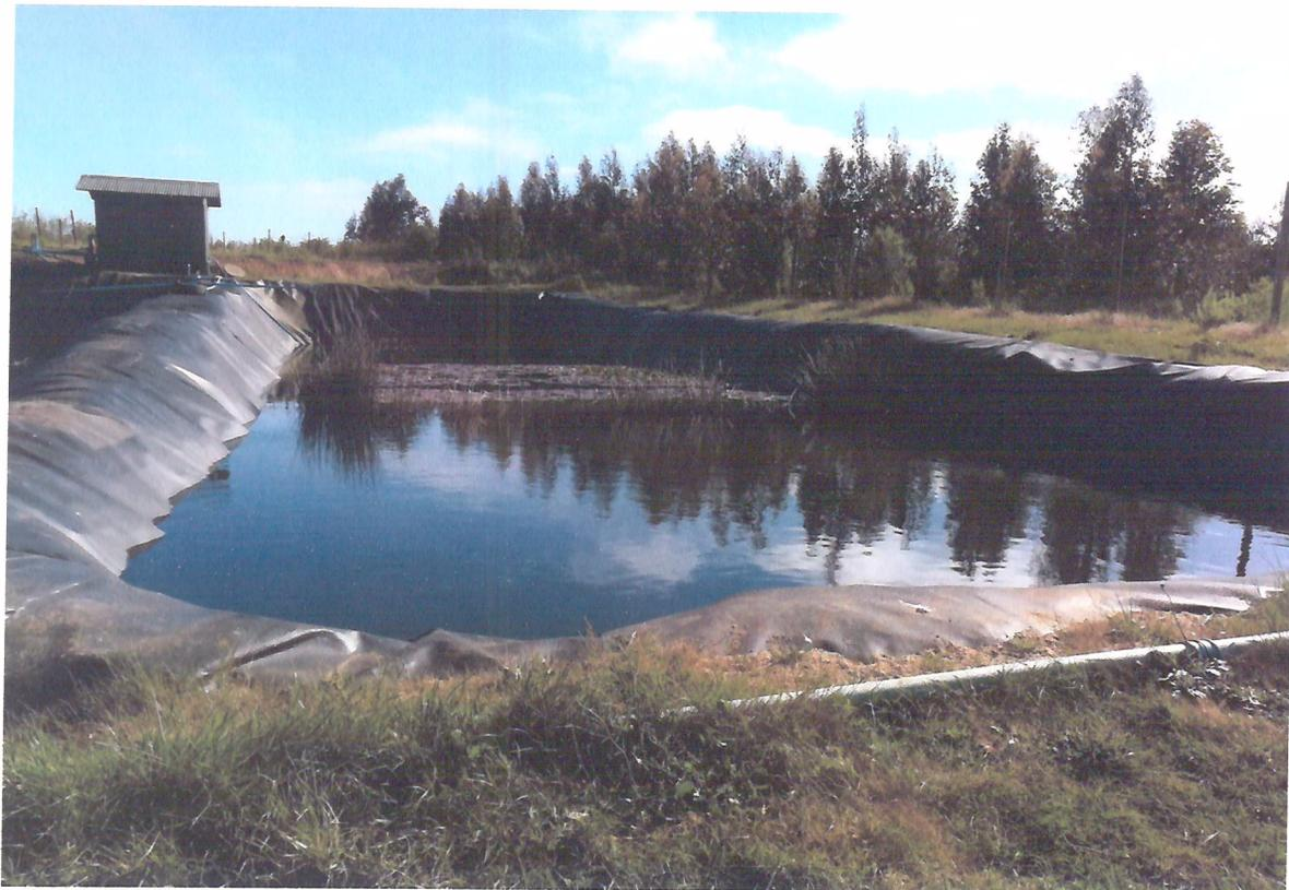
**Figura 2:** Piscinas Palustres, se observan las 2 piscinas palustres del Relleno Sanitario. Se destaca línea que permite circulación desde zona de tratamiento físico químico a piscinas palustres
