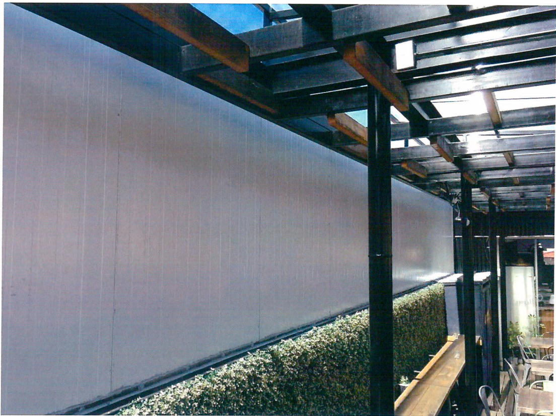
Muro de paneles modulares de ispol, techumbre y pasto sintético vertical.
