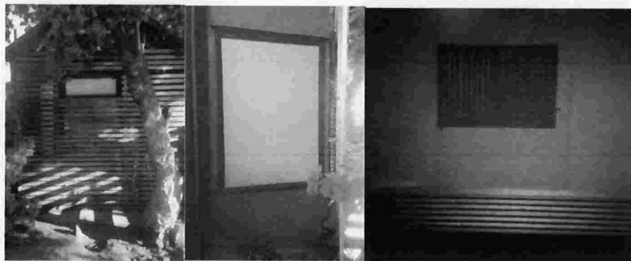
Filtro paredes salón de baile instalados dos ( paredes terminadas con aislante de roca lamina de corcho y aislapol y placa yeso)
