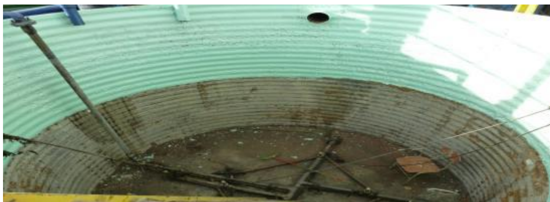
Foto N° 13: Se realiza vaciado de estanque y limpieza de PTAS
