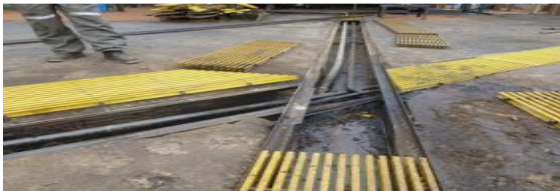
Foto N°8: Se instalaron rejillas (greeting) nuevos en canaletas colectoras
