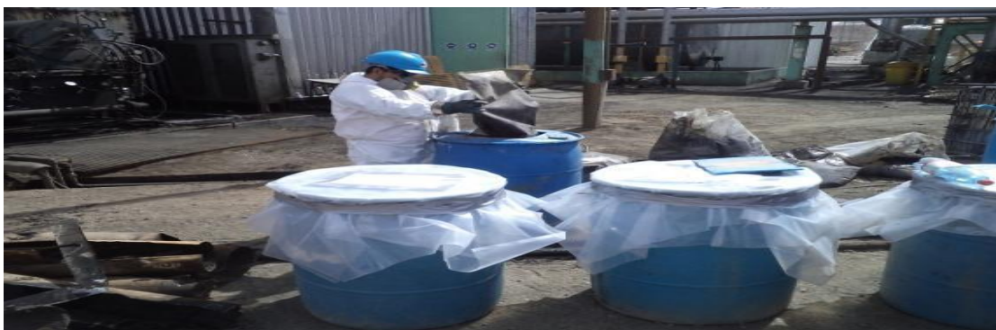
Foto N°6: Se almacena material contaminado en contenedores especiales y rotulados.
