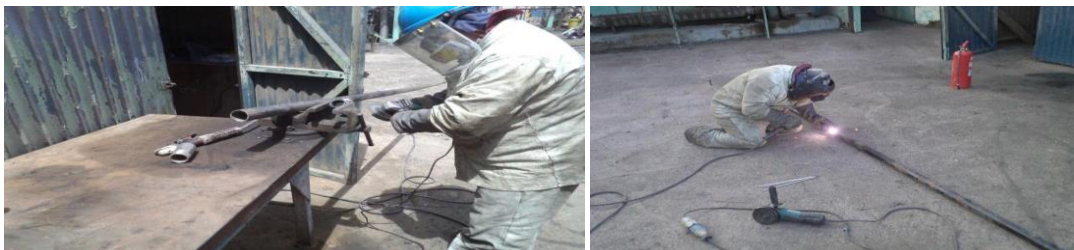
Foto N°7: Mecánicos empresa Chance delimitan sector y preparan tramos de cañería, para luego ser instaladas.
