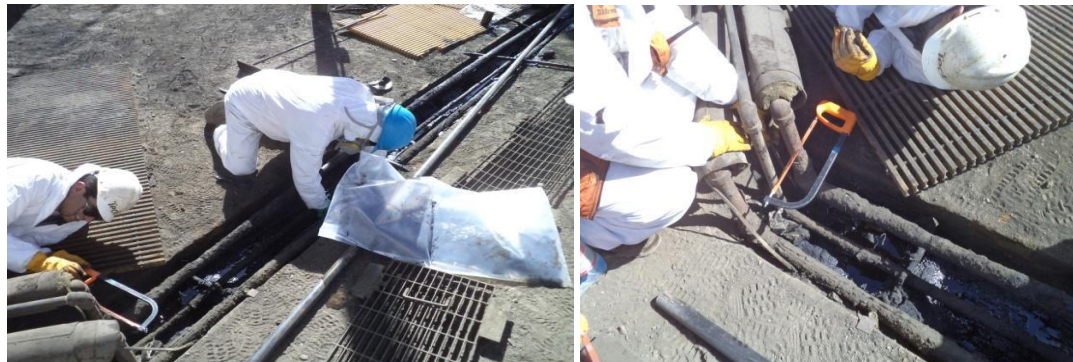
Foto N°5: Personal de la empresa Chance realiza retiro de tramo de cañería en mal estado del sistema de retorno de los Calentadores Electrolitos Planta.
