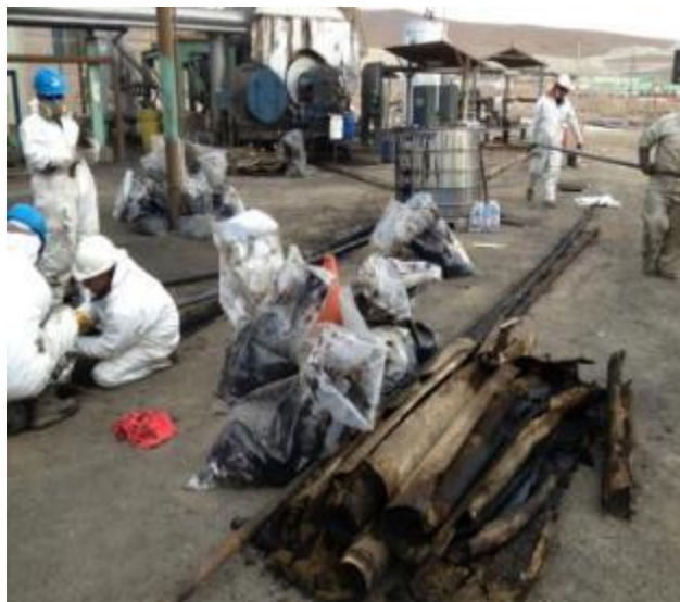
Foto N°2: Cambio de tuberías el día 3 de Enero de 2013, producto de fuga de petróleo bunker en sistema de recirculación
