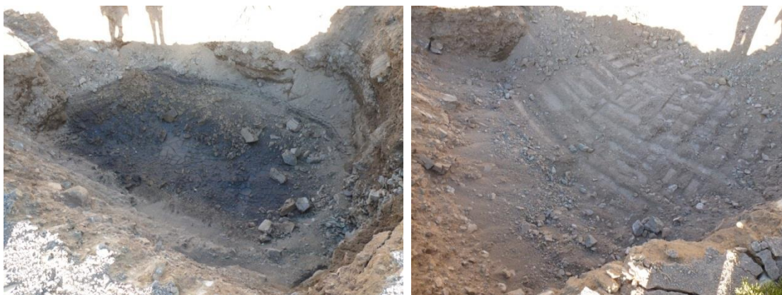
Foto N° 9: Se confeccionan dos calicatas con capacidad de 6 m 3 cada una.
