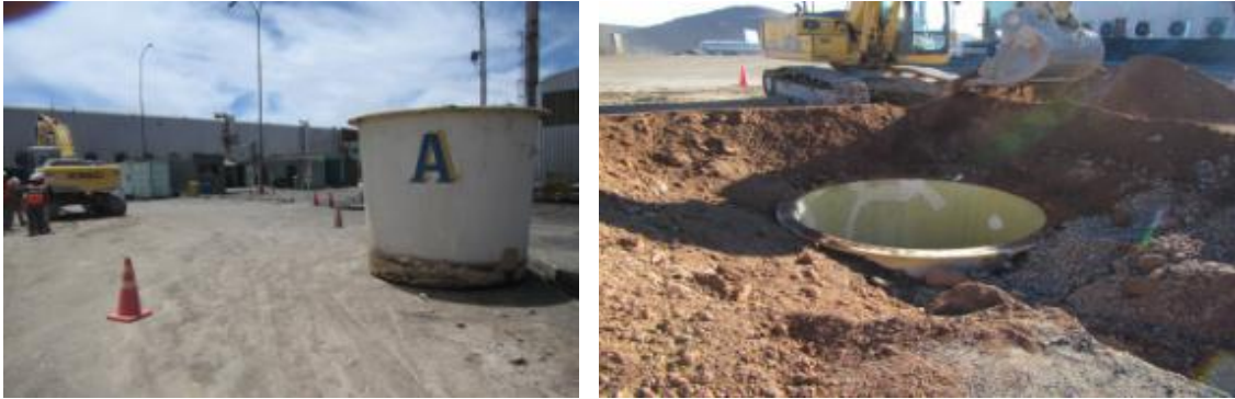
Foto N°12: Instalación de estanque de contención.
