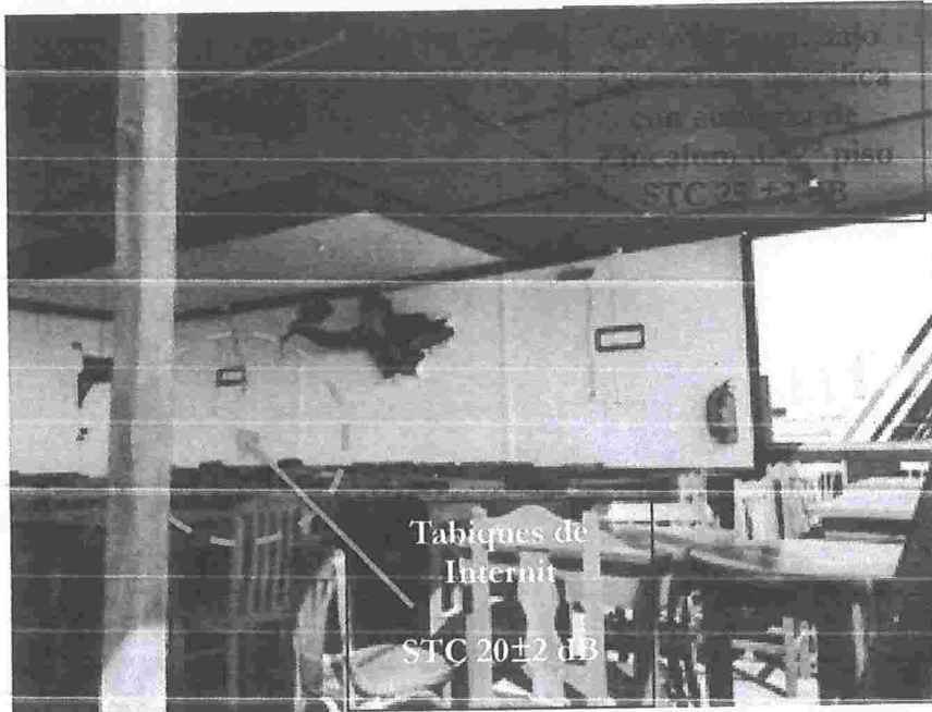
Imagen 8: Tabiques STC 20 \pm 2 dB y Cielo STC 25 \pm 2 dB
