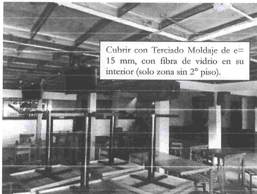
Imagen 11: Pista Baile primer Piso, Refuerzo de cielo.
