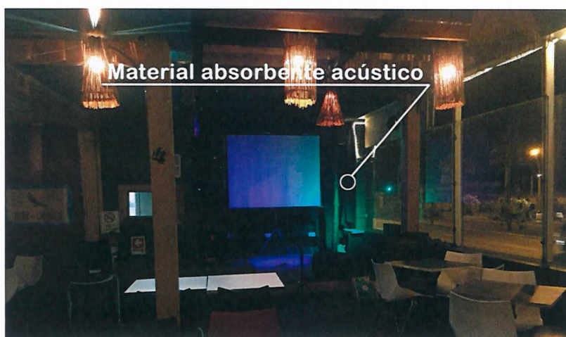
Figura 10. Material absorbente acústico en el escenario del primer piso.
