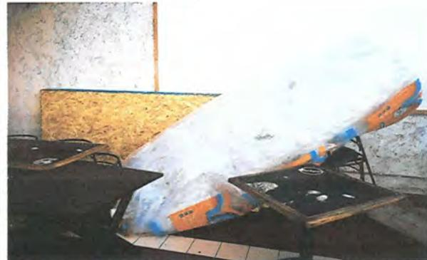
Foto de la modificación en la terraza del local, se instalan paneles intercalados (unos arriba y otros abajo, para darle la salida al humo de cigarrillo)
