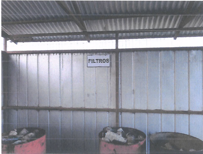
Rotulación Contenedores de Filtros
