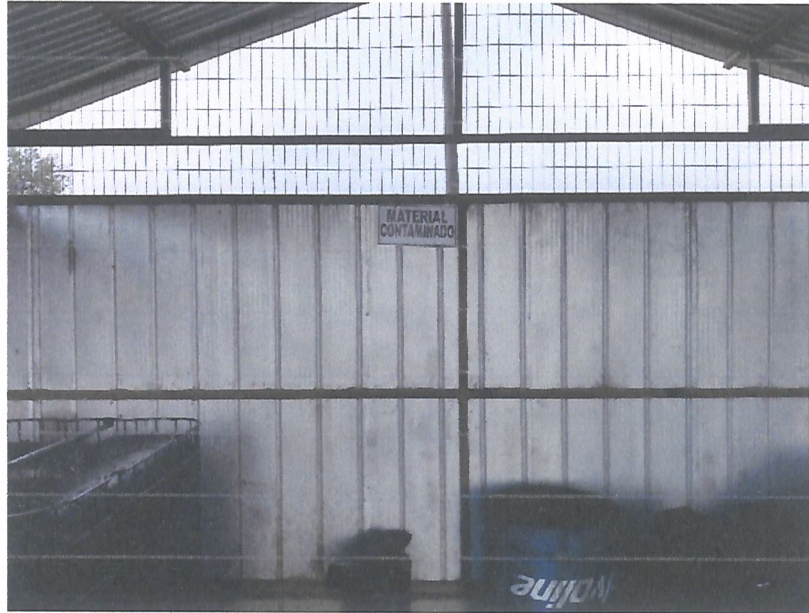
Rotulación receptáculos Material Contaminado
