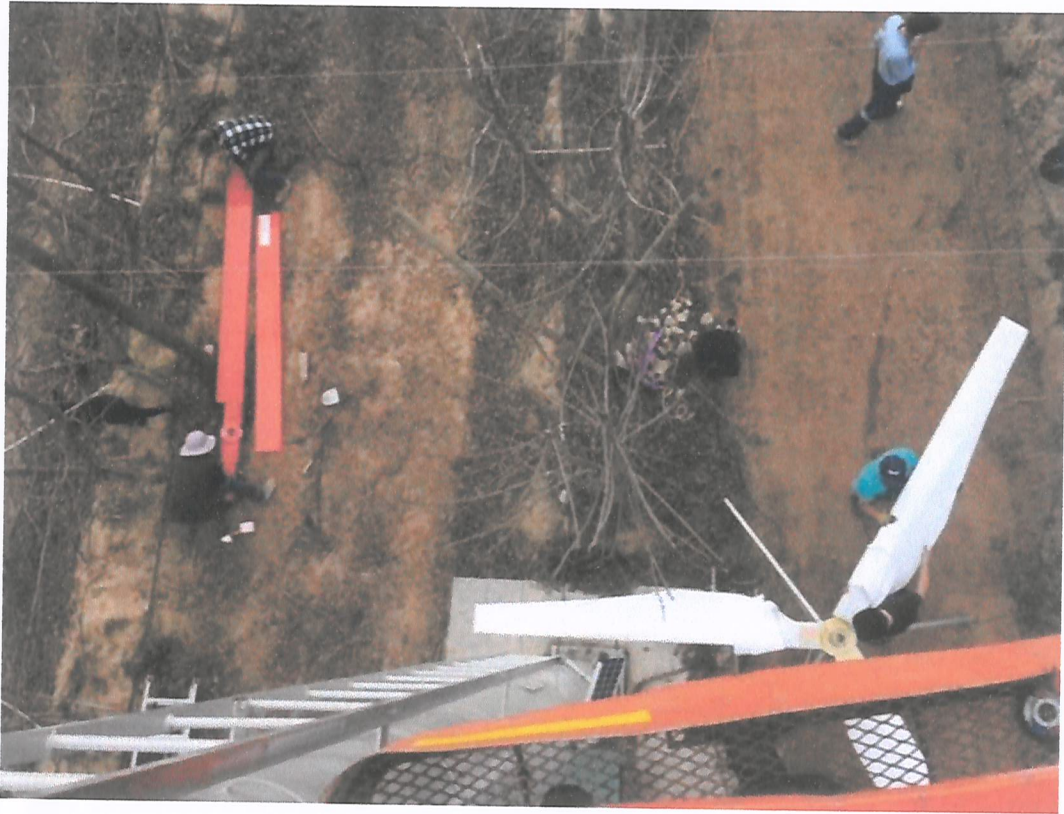
MONTAJE DE HELICES DE 3 ASPAS
