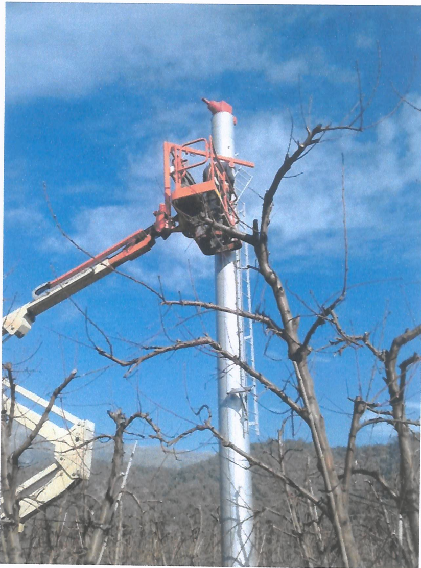
DESMONTADA LA HELICE DE 2 ASPAS
