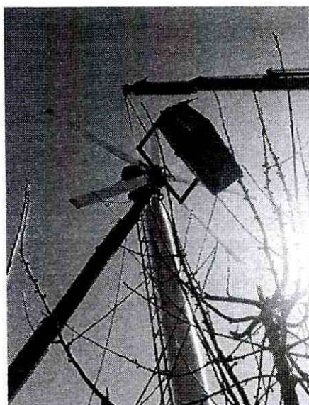
Instalación hélice de cinco aspas, Chillán.
