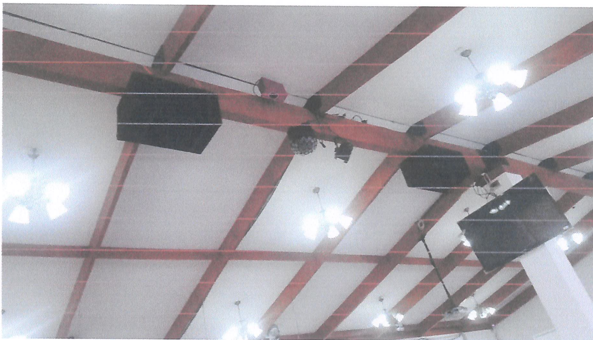
IMAGEN N° 5: Parlantes adosados a Viga. Todas las fotografías fueron tomadas el día 12P de Diciembre de 2019, en Salón de Eventos Cayros ubicado en calle Manuel Rodríguez número 977.
